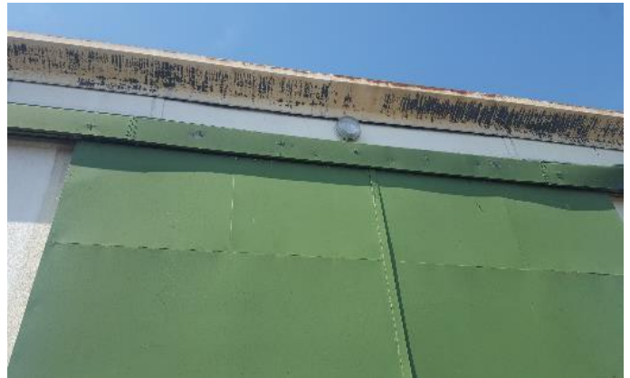
Prospection des fissures des façades de bâtiments visant à détecter la présence de gîtes de chauves-souris
